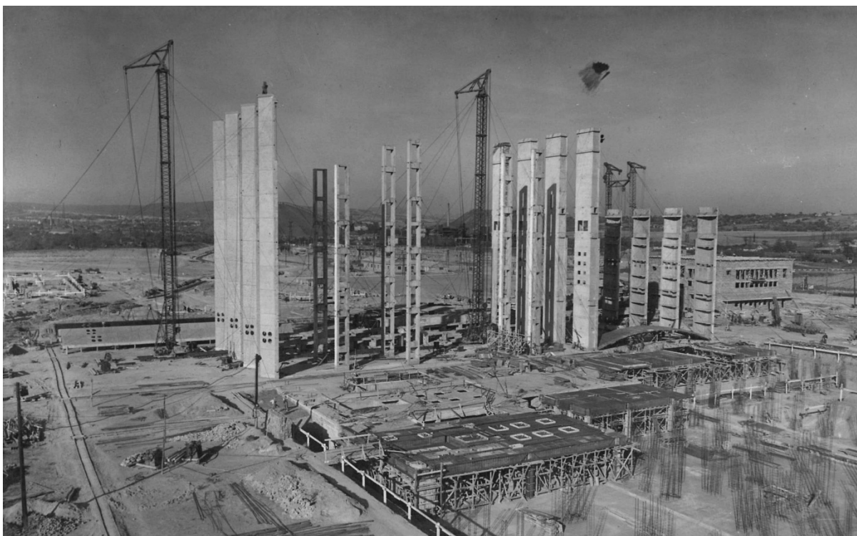
2.kép Építési helyszín a már álló teherhordó homlokzati elemekkel. Jobbra a kisebb belmagasságú turbinacsarnok, a készülő a földémdongával. Balra a négyhajós kazáncsarnok épülő részlete No. 2773
