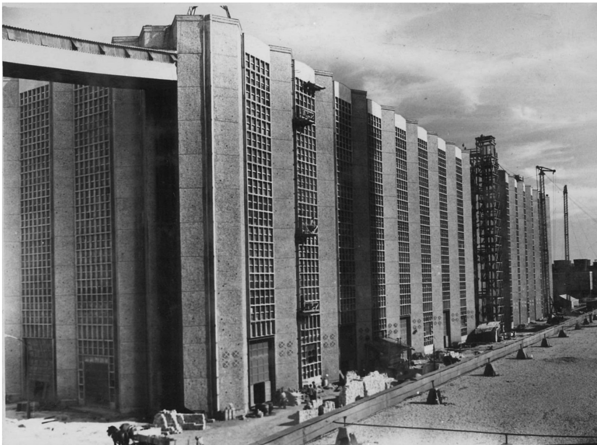
11.kép A kazáncsarnok homlokzati részlete No. 4551
