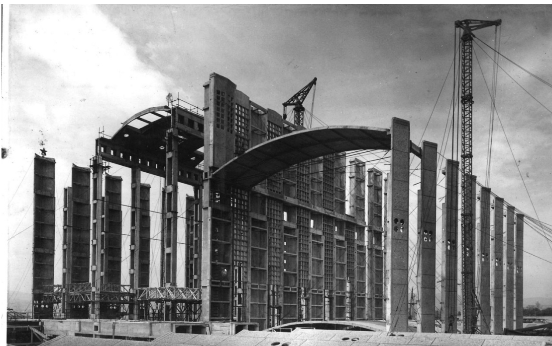
5.kép Az épülő erőművi főépület most a turbinacsarnok felől nézve. Itt a fesztáv 24,8 m. No. 2955
