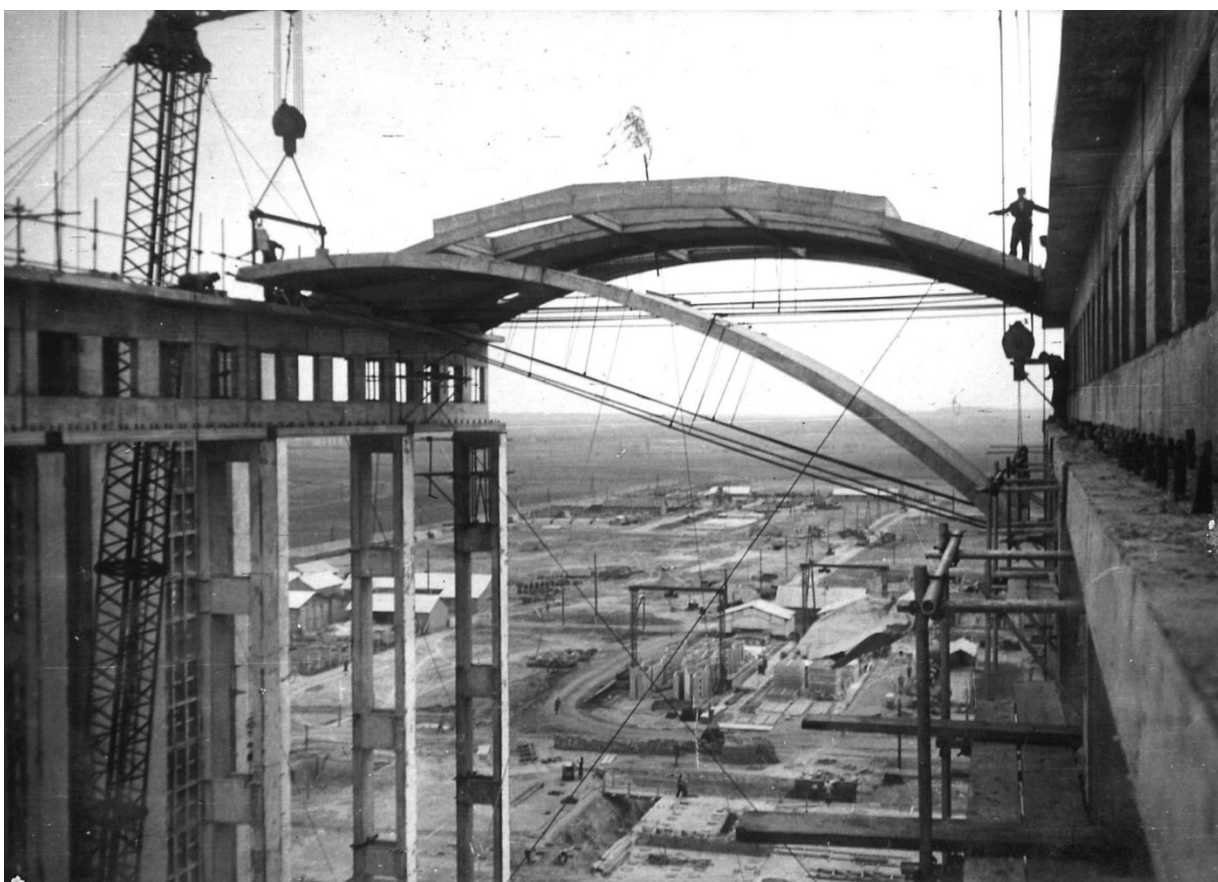
3.kép A kazáncsarnok vonórudas tetőpaneljének elhelyezése No. 2945
